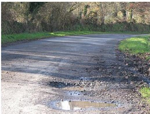
L'hiver, un différentiel important de température sur un nombre de jours restreint fragilise le revêtement des chaussées. Elles peuvent alors se fissurer. La pluie va s'infiltrer dans les sous-couches de la chaussée. Si elle gèle, elle prend plus de volume et lors du dégel, l'eau s'écoule et des trous apparaissent. Notre commune est située dans une zone de marais. Le sous sol est de ce fait instable et accentue le phénomène. Les nids de poule peuvent également apparaître à la suite de travaux.
